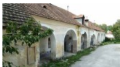
Hrad, zámok, pamiatka, 7000 m 2 , pôvodný stav, tehlová konštrukcia objektu
